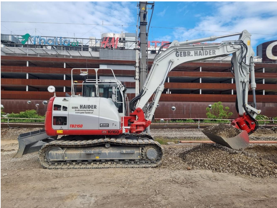
Die Gebrüder Haider Bauunternehmung hat ihren Takeuchi-Bagger mit einer Topcon-Maschinensteuerung ausgestattet.
