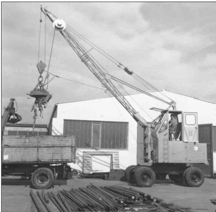
1962: Seilbetriebener S833 mit erhöhter Fahrerkabine
